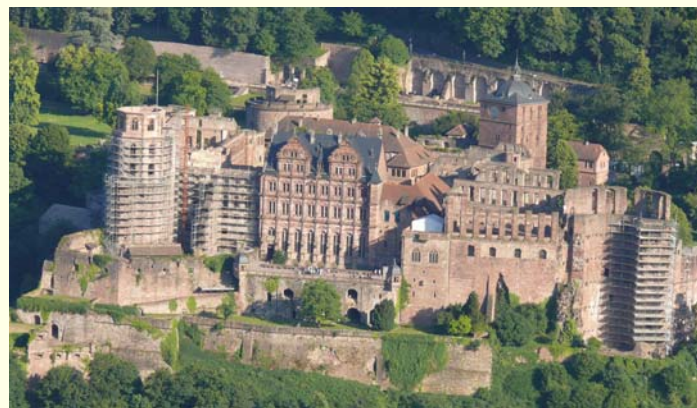
Abb. 4: Schloss Heidelberg, eines der bekanntesten historischen Bauwerke Deutschlands, erbaut aus Sandsteinen des „Heidelberger Bausandsteins“ und des „Neckartäler Hartsandsteins“.
