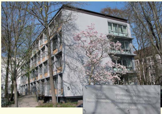
Abb. 2: Regierungspräsidium Freiburg, Landesamt für Geologie, Rohstoffe und Bergbau, Dienstgebäude Albertstraße 5.
