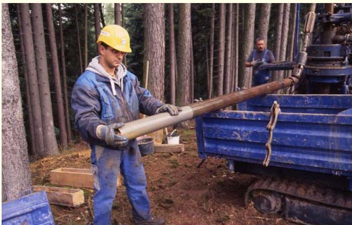
Abb. 3: Durchführung von Kernbohrungen durch das LGRB zur Erkundung des Unteren Donzdorfer Sandsteins bei Lauchheim (2008).
