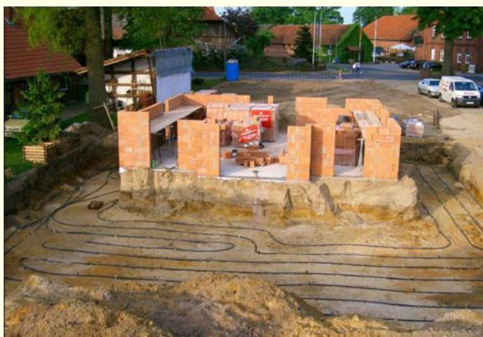
**Abb. 1:** Horizontal verlegte Rohrleitungen einer Erdwärmekollektorenanlage (Foto: Der Wärmepumpenpartner GmbH).
