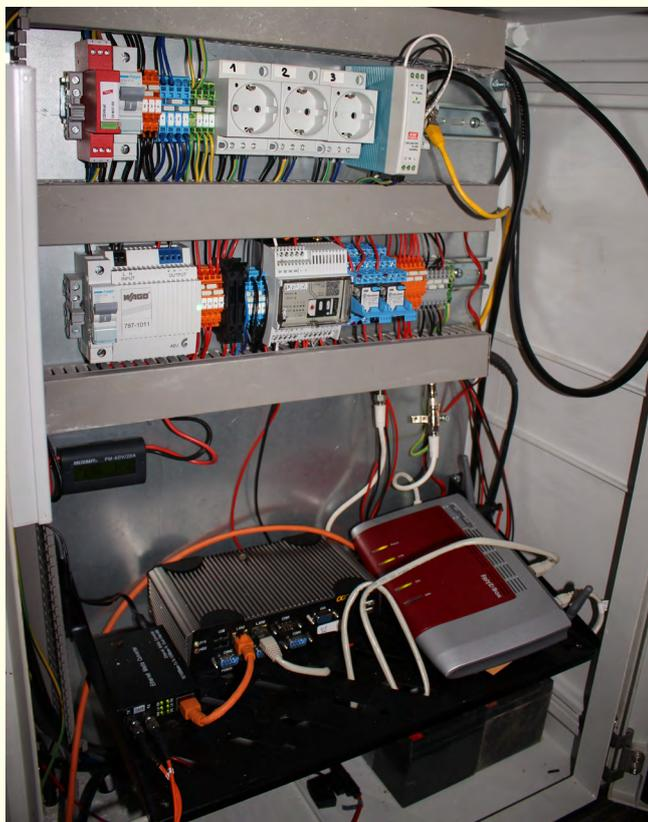
**Abb. 2:** Elektronisches Innenleben einer Erdbebenmessstation mit Stromversorgung, Kommunikationseinrichtungen, Registerereinheit mit GPS-Zeitsynchronisation und Fernüberwachung und -steuerung; das Seismometer zur Messung der Bodenbewegung ist ungestört und in einiger Entfernung zu diesem Schaltkasten aufgestellt.
