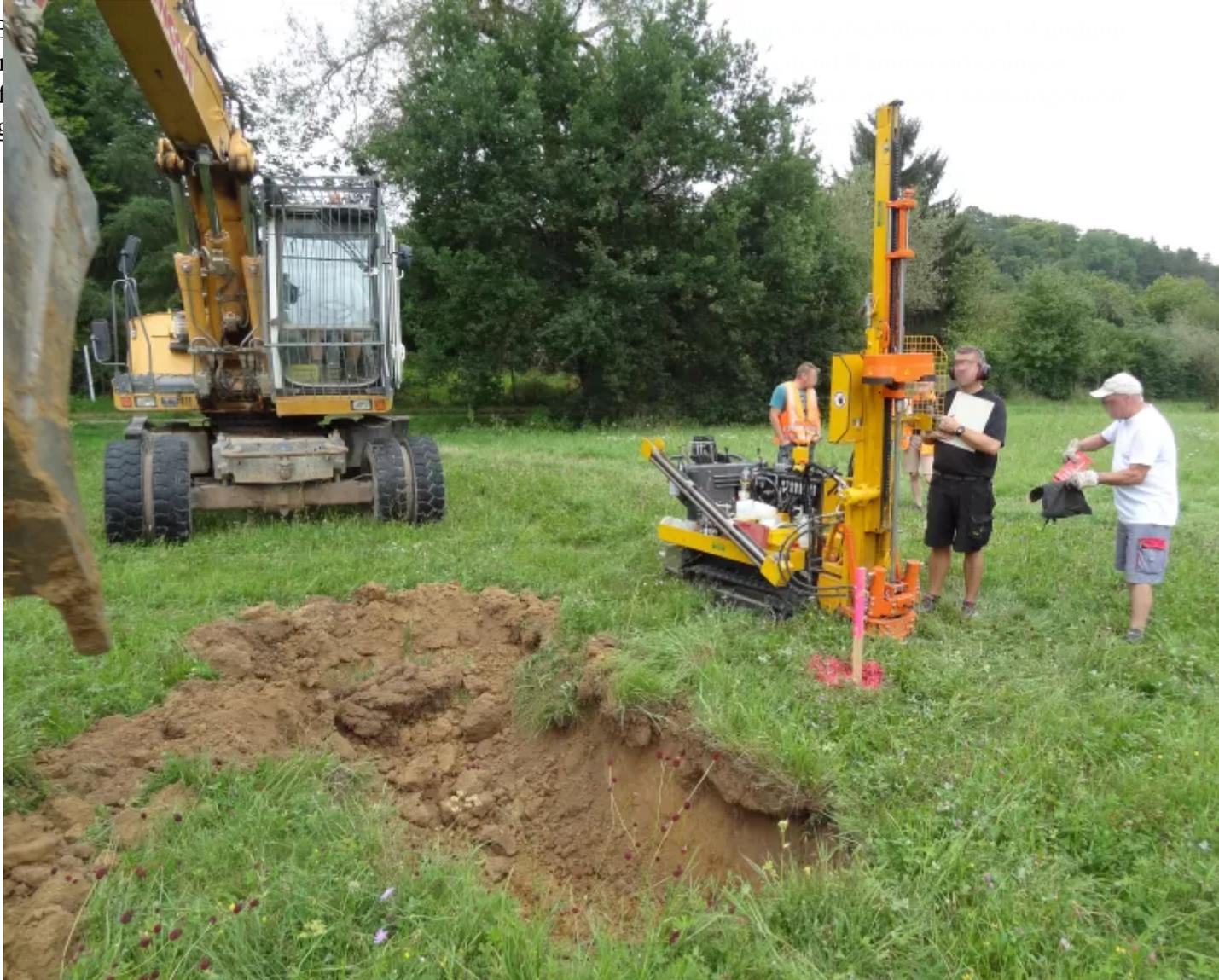
Baggerschurf (links) und schwere Rammsondierung (dynamic probe heavy, rechts) zur Erkundung des Voreinschnittsbereichs des Arlinger Tunnels, Pforzheim
