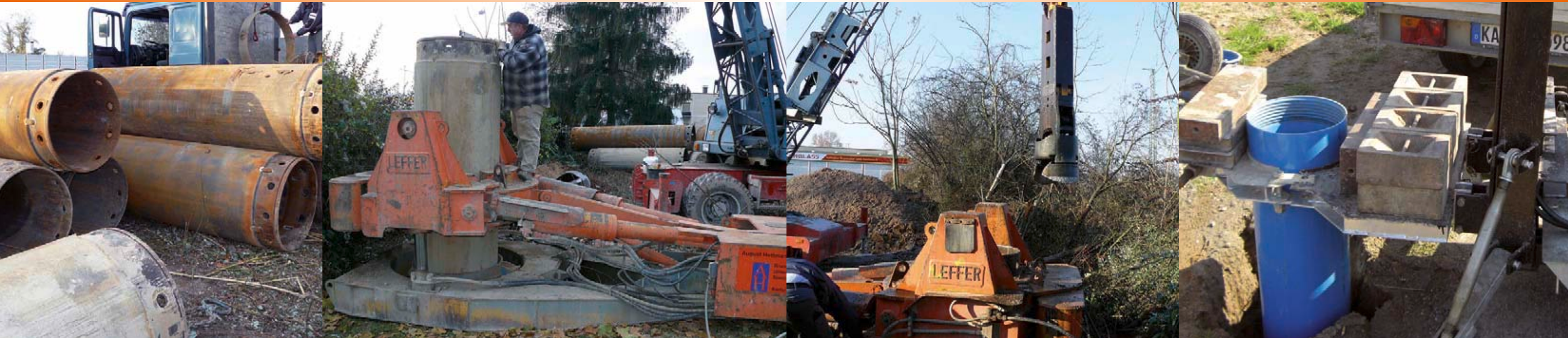
Brunnenbohrung, links: Stützverrohrung für einen großkalibrigen Grundwasserwärmbrunnen in Neckarschottern (Durchmesser 880 mm); rechts: Justierung der Stützverrohrung an der Verrohrungsmaschine des Bohreräts (Bildquellen: Dipl.-Geologe H. Weyersberg, Bietigheim-Bissingen).
