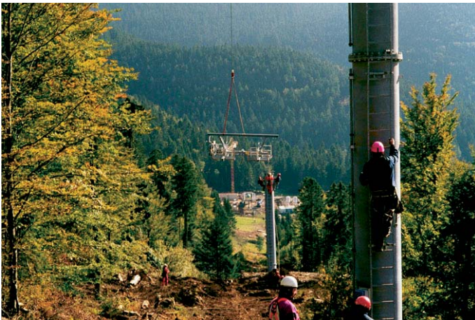
Montage einer Rollenbatterie
