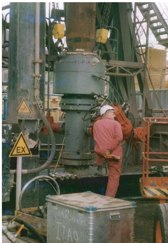
Abb. 1: Bohranlage beim Niederbringen einer Geothermie-Tiefbohrung (Foto: LGRB)
