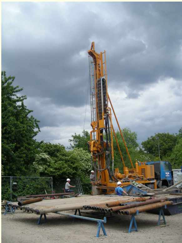
Abb. 1: Die Bohrstelle in Heidelberg im Sommer 2008, nachdem die Endteufe von 500 m erreicht war (Foto: LIAG).
