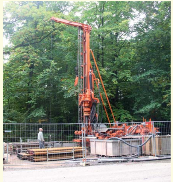
Forschungsbohrung Juxkopf-2 im September 2013.
