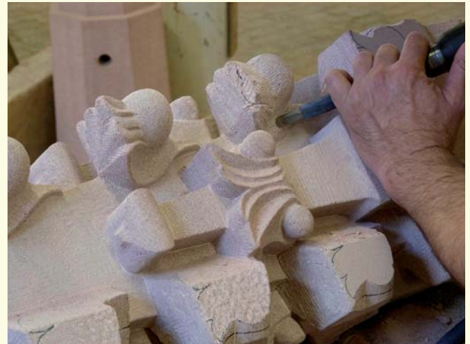
Abb. 2: Herstellung einer neuen Fiale für das Freiburger Münster aus Lahrer Buntsandstein in der Freiburger Münsterbauhütte (Foto: W. Werner).
