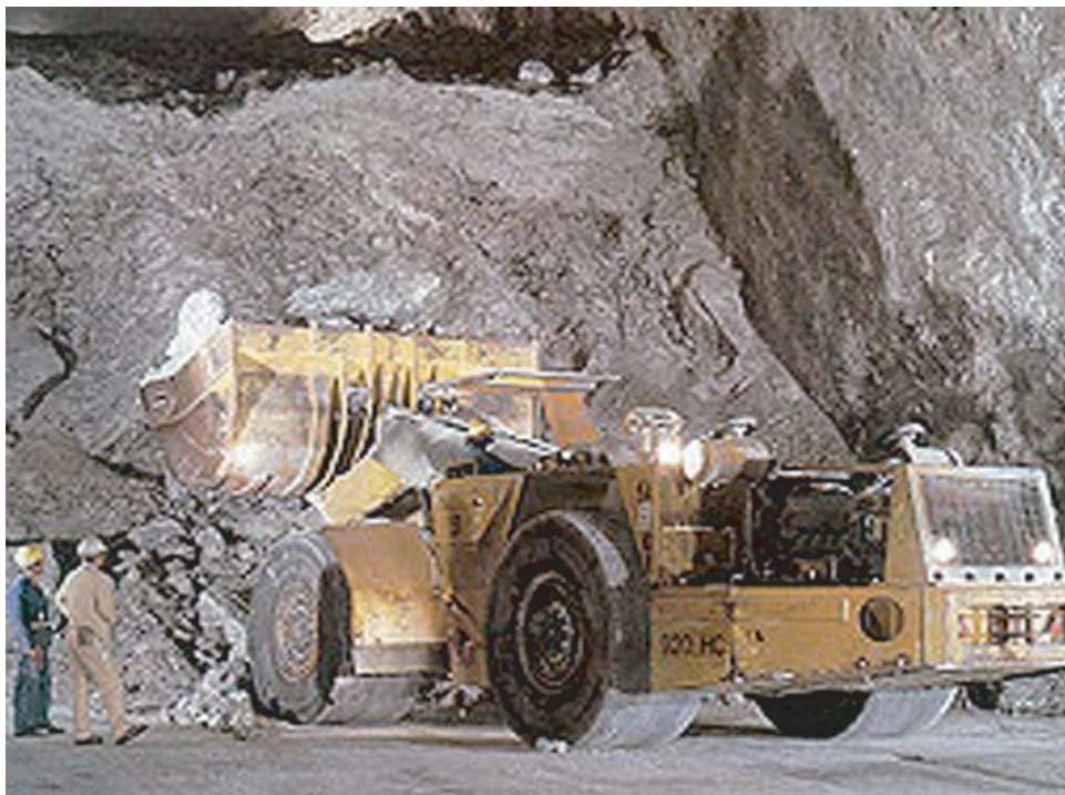
Abb. 2: Fahrschaufellader beim Laden des gesprengten Steinsalzes in der Kammer
