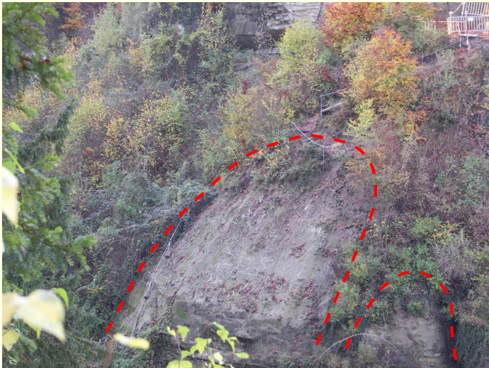
Abb. 1: Nordhang der Schlucht mit Abrissgebieten der Oberflächenrutschungen
