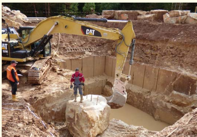
Probeabbau im Oberen Stubensandstein (2014), Waldgebiet Oberer Neubronn, Gemeinde Waldenbuch; beauftragte Firma: Fa. Lauster Steinbau, Stuttgart.
