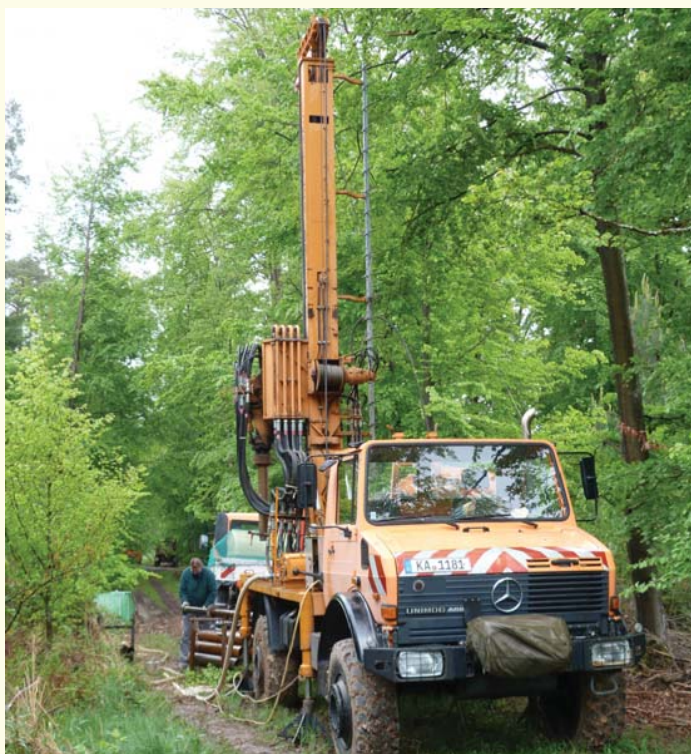
Aufschlussbohrungen (2012) im dichten Waldgebiet des Schönbuchs östlich von Dettenhausen zum Nachweis einer für die Werksteingewinnung ausreichend mächtigen und kompakten Sandsteinschicht.
