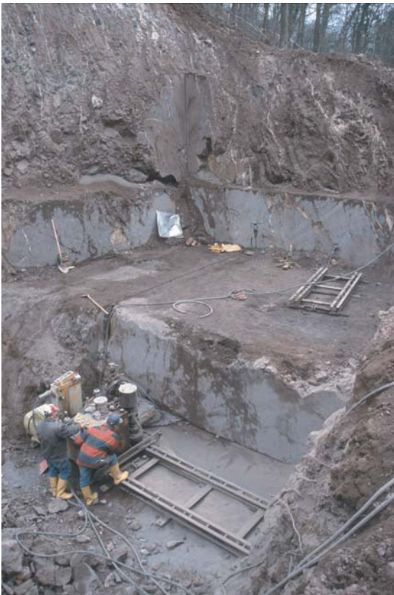
Bild 3: Abbau mit der Schrämsäge
