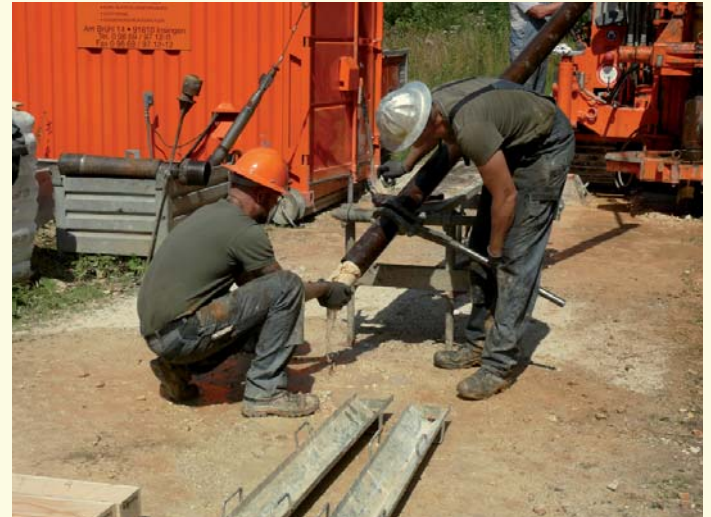
Abb. 5: Gewinnung von Bohrkernen an einer LGRB-Erkundungsbohrung (2013) nahe Heidenheim-Großkuchen zur Ermittlung von Qualität und nutzbarer Mächtigkeit von Kalksteinvorkommen.
