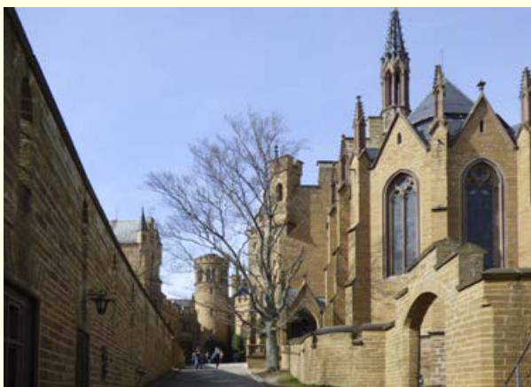
Abb. 3: Links: Burg Hohenzollern bei Hechingen, erbaut überwiegend aus Angulatensandstein, der in zahlreichen kleinen Steinbrüchen im nördlichen Vorland der Burg gewonnen wurde. Rechts: Gewinnung von Angulatensandstein im Probeabbau bei Grosselfingen im Juni 2018.
